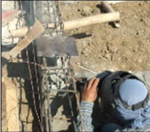
**Nota:** En la figura 30 se visualiza la aplicación inadecuada de la soldadura, por otra parte, se identifica el pandeo de la placa provocado por el insuficiente espesor de esta, así también como el material de baja calidad.
