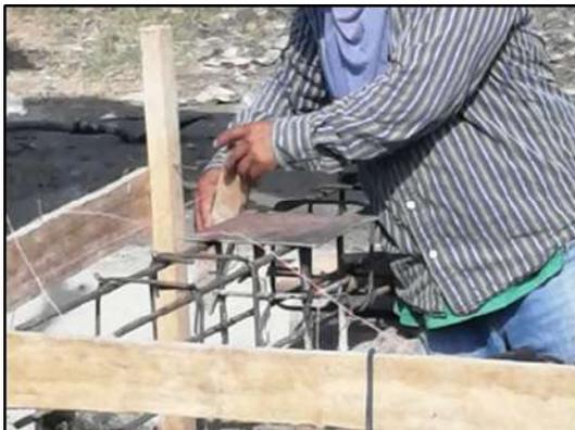
**Nota:** En la figura 28 y 29 se muestra que la placa no consta con un correcto anclaje, no presenta barras, roscas y pernos para la fijación de la misma.
