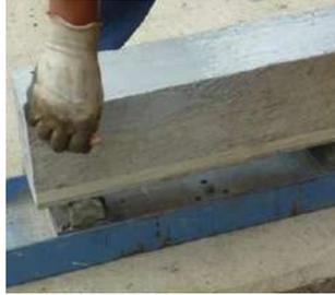
Aplicada esta primera capa de epóxico se coloca la fibra curada y húmeda sobre el sustrato seco de epóxico aplicado en la viga y se sujeta firmemente la fibra por medios mecánicos al elemento para evitar que se suelte antes de secar.
