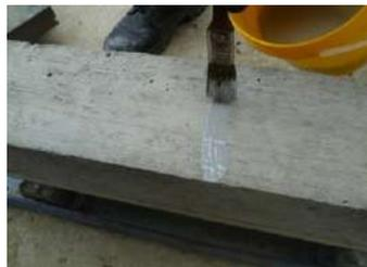
Luego se procede a recubrir la superficie del elemento con la misma mezcla de epóxico a fin de proporcionar un sustrato firme y sellado para la fibra, durante el proceso es necesario el uso de guantes, ropa protectora y bastante ventilación, puesto que el epóxico es volátil y de olor y tacto bastante agresivo.
